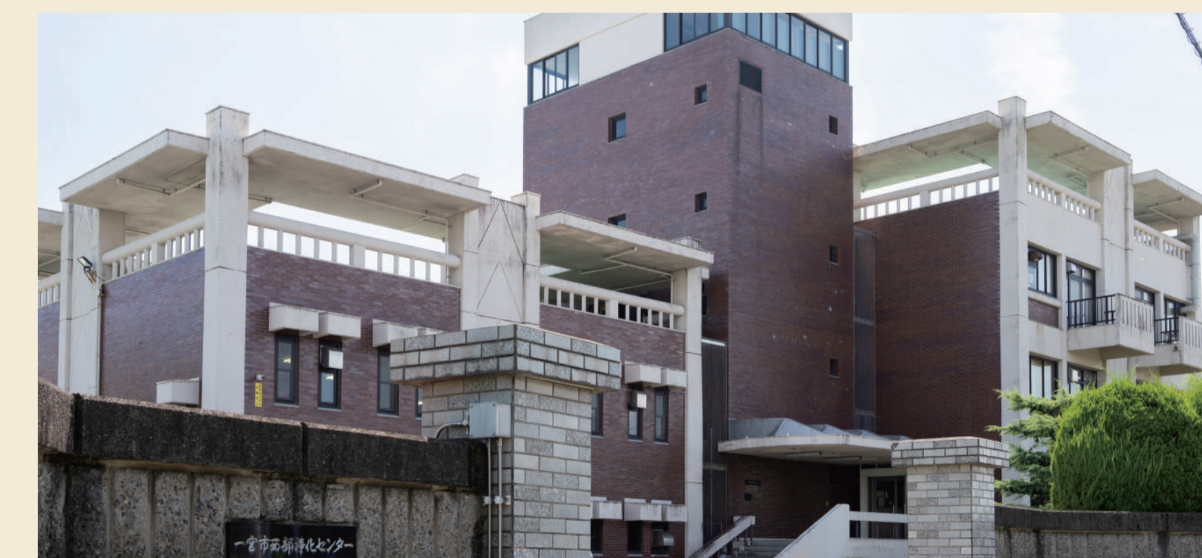
一宮市西部浄化センター
